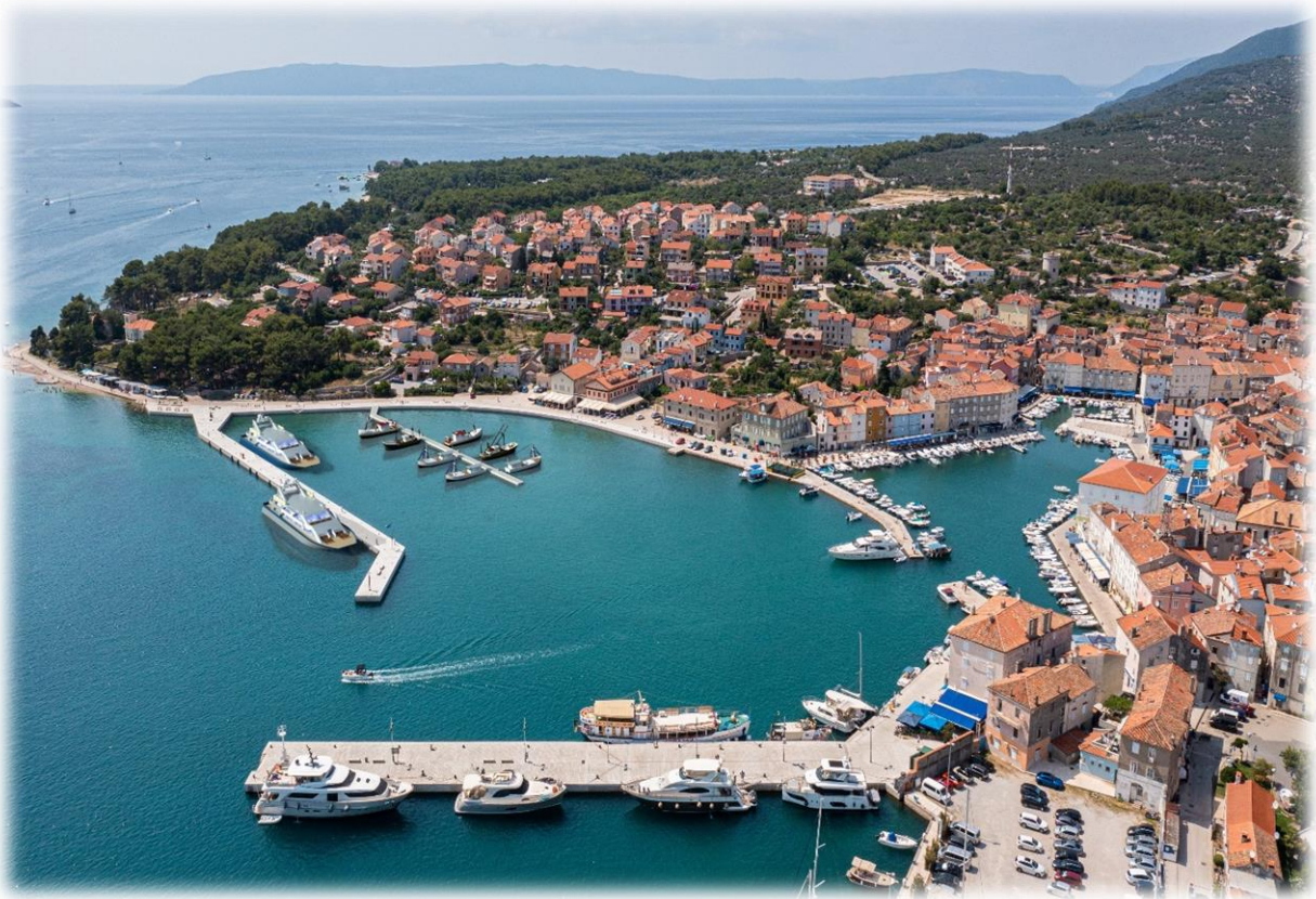
Rekonstrukcija i dogradnja zapadnog dijela luke Cres
