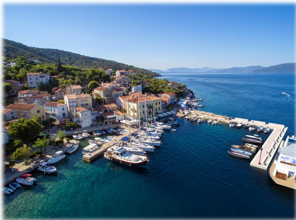
Rekonstrukcija i dogradnja luke otvorene za javni promet lokalnog značaja – luke Valun- prva faza
