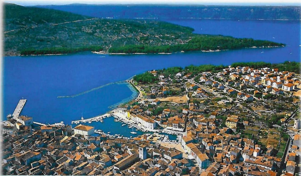
Rekonstrukcija i dogradnja zapadnog dijela luke Cres
