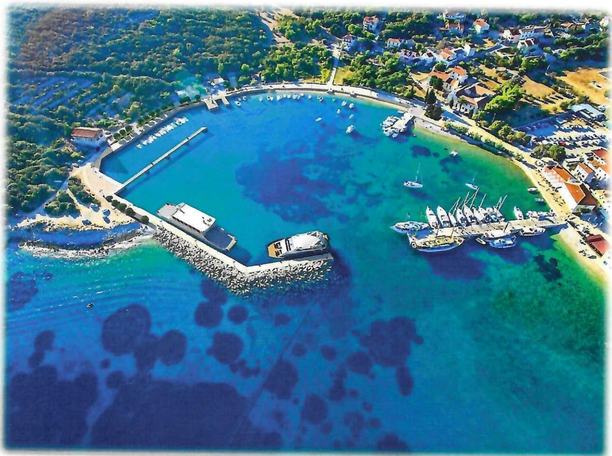
Rekonstrukcija-dogradnja luke otvorene za javni promet u naselju Martinšćica na otoku Cresu
