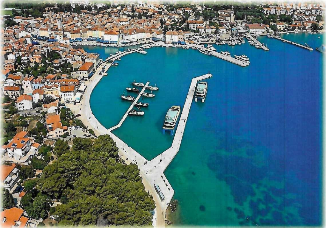
Rekonstrukcija i dogradnja zapadnog dijela luke Cres – III faza
