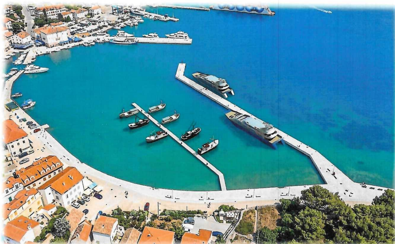
Rekonstrukcija i dogradnja zapadnog dijela luke Cres – III faza
