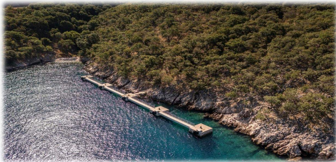
TP Porozina – uvala Trebenež
