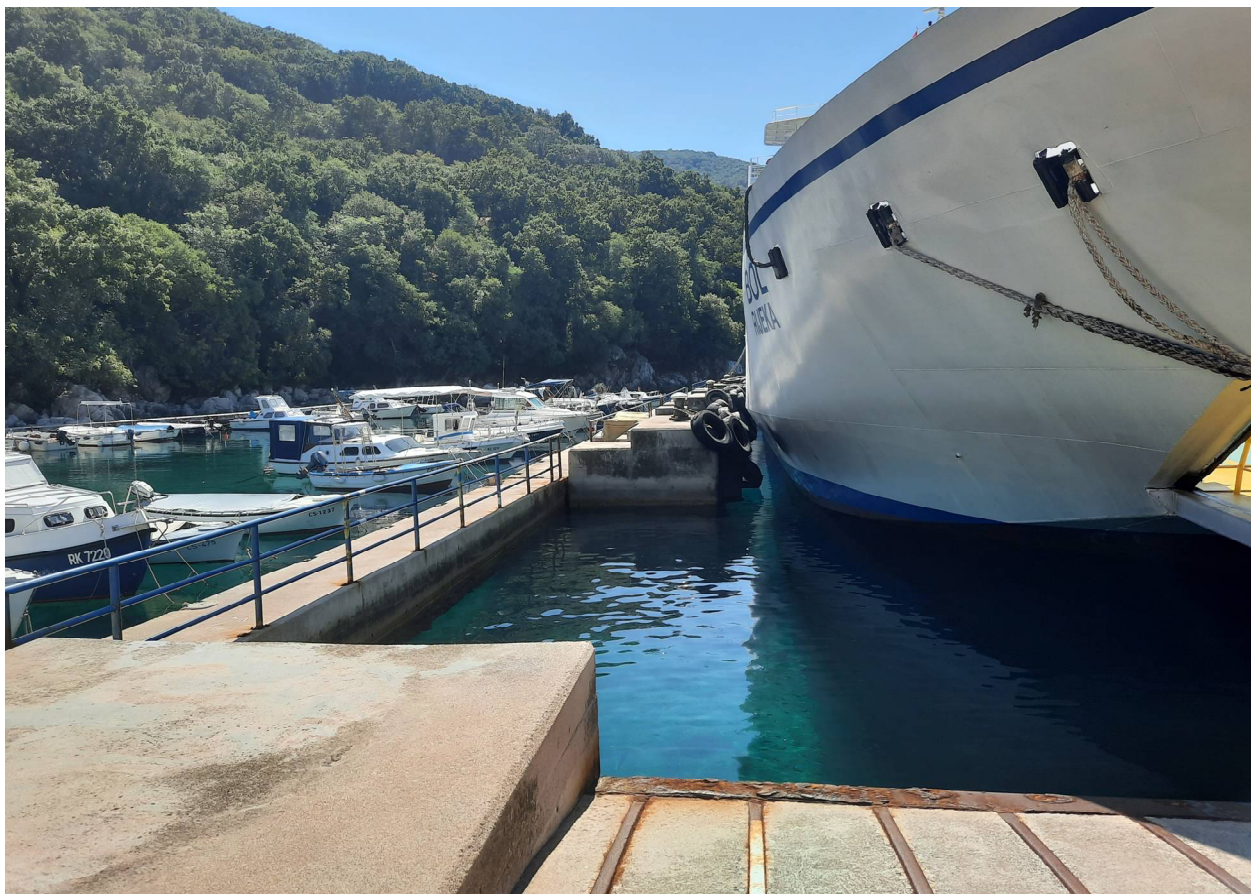
Slika 2. Pogled na istočni vez TP Porozina
