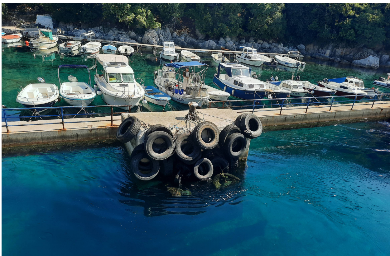
Slika 3. Postojeće kamionske gume preko gumenih odbojnika - jedna od obaloutvrda
